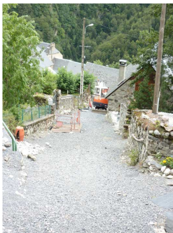
Hameau d'Eget avant les travaux © PNP
