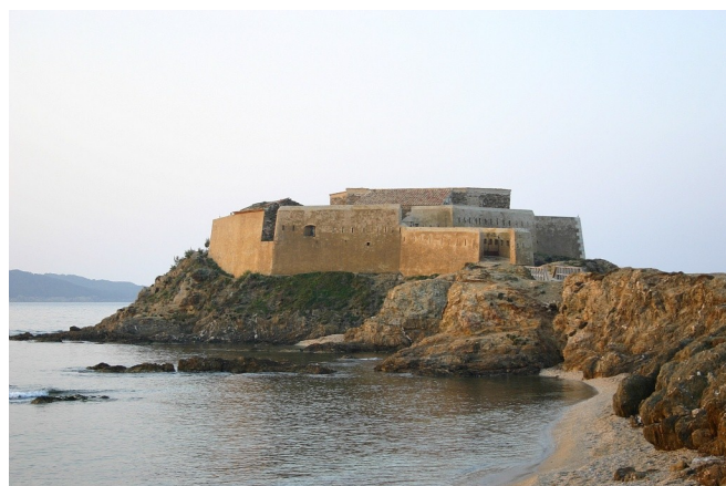
Batterie du Pradeau - © PNPC
