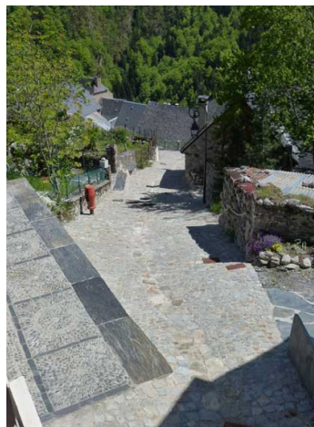
Hameau d'Eget après les travaux © PNP
